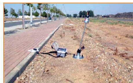
[Fig. 12] .- Control de compactación de relleno.
