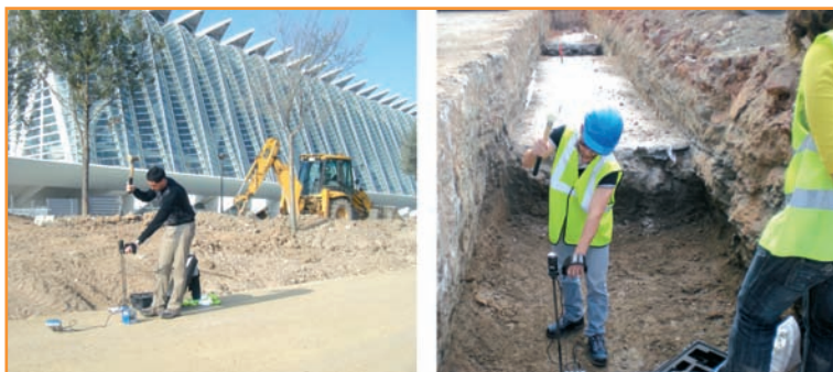
[Figura 5].- Reconocimiento del suelo y ensayo de resistencia del terreno en zanjas.
