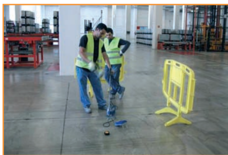
[Fig. 8].- Comprobación de la compactación bajo solera de los rellenos en una fábrica.
